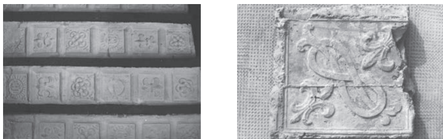
Figg. 15 e 16 - Un soffitto in gesso conservato ed un frammento reperito in discarica (Archivio A. Adriano)
